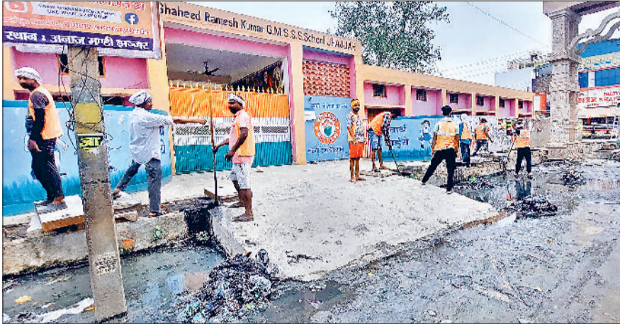
झज्जर। शहर के भट्टी गेट क्षेत्र में नालों की सफाई करने में जुटे कर्मचारी।
